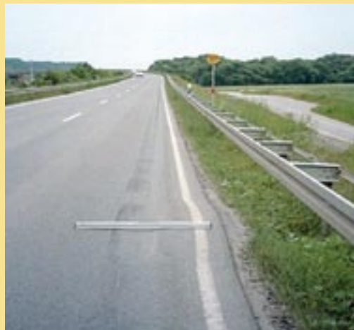
Schäden an der Asphaltdecke (Spurrinnen)
